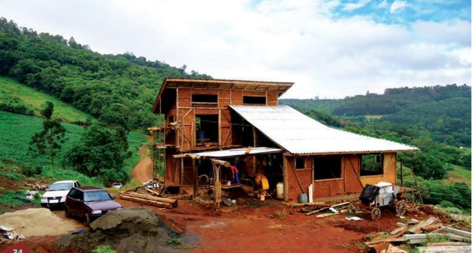
Bioconstrução em propriedade rural, Cresol Central SC-RS
